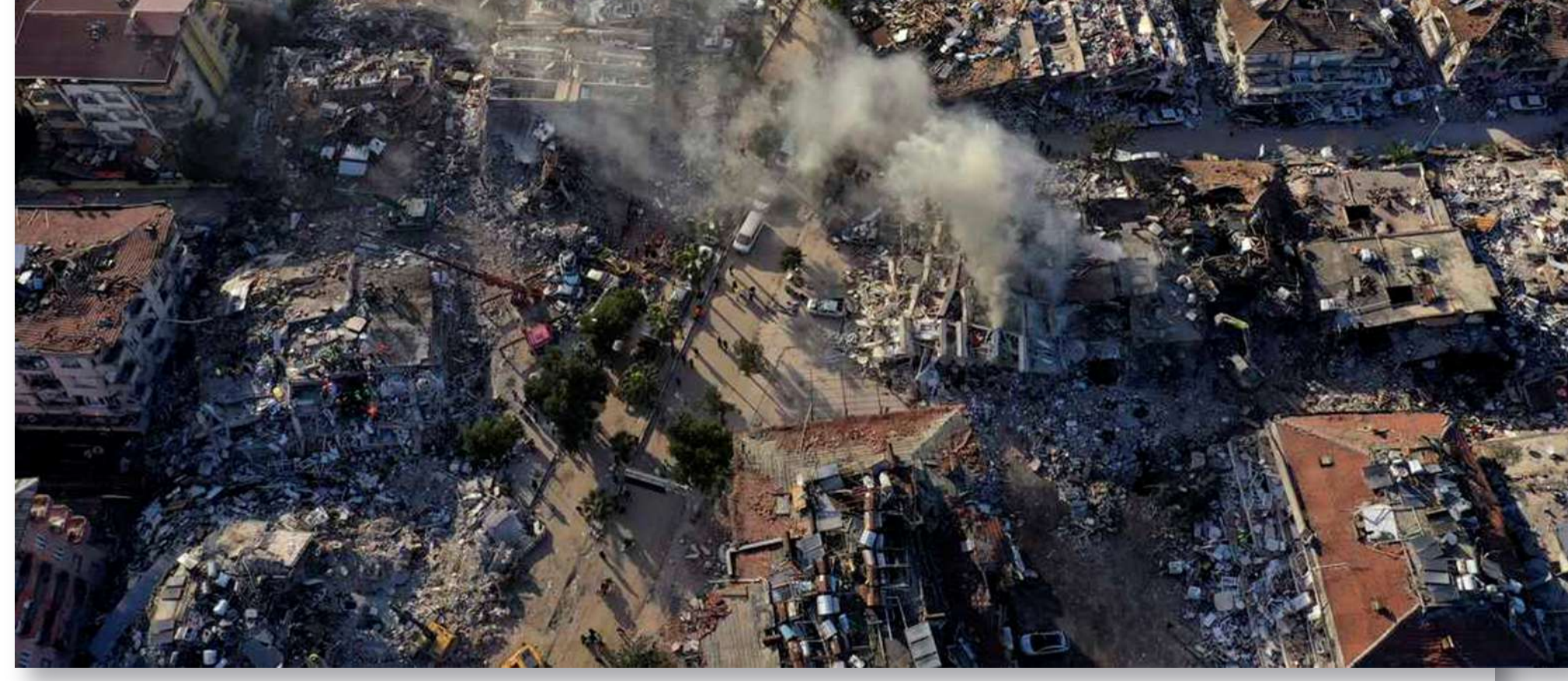
Figura 1. Vista una de las zonas afectadas en Antakya, Turquía
